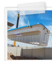
Installation de piscines coques
