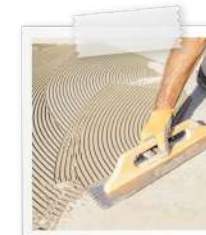
Pose d'enduits, revêtements plastiques d'étanchéité
