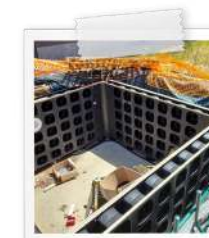
Installation de piscines à panneaux modulaires
