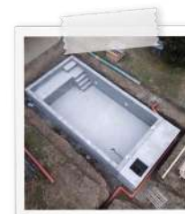
Piscine à structure en béton
