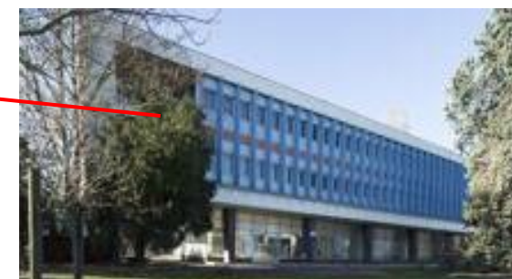
Ancienne usine gazière bâtiment social garage vestiaires, Alfortville, Inscrit MH 2011
