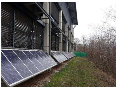
Halle de Gymnastique 10 kWc – 2007 – Vente Totale
