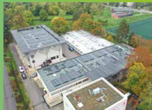
Couverture photovoltaïque de l'école Buffon du quartier Fontaine d'Ouche.
