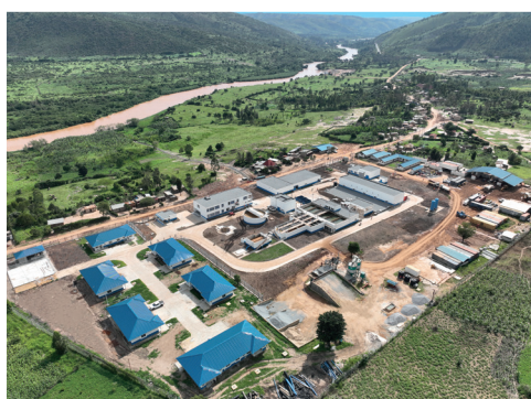
Hydraulique - WTP de Kagera en Ouganda
