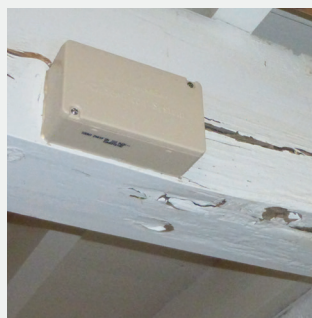
Boîtiers Sentries, discrets et sécurisés, placés sur les zones de passage des termites
