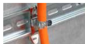
Montage sur rail DIN type H
