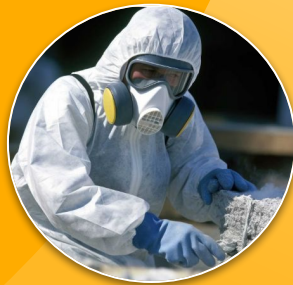
Gestion de l'amiante Prestations sous section 4
