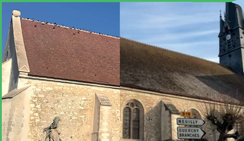
Nettoyage toiture et façade - Église de Senan
